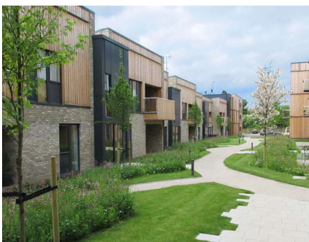
Plasticiteit in de gevels
