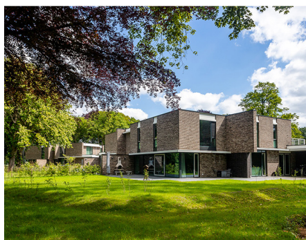
Woningen ogen kleinschalig
