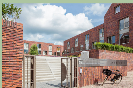
Toegang mee-ontworpen met hoofdmassa
