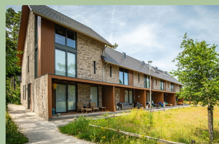
Individuele veranda met beperkt hoogteverschil naar maaiveld
