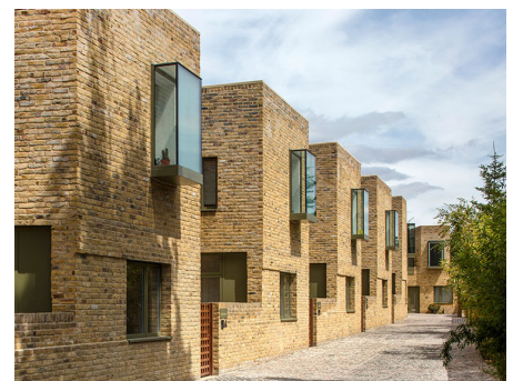
Plasticiteit in de gevels
