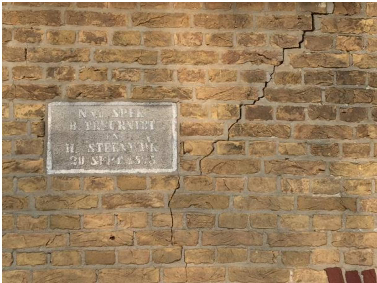
Scheur gevel voorhuis plaquette
