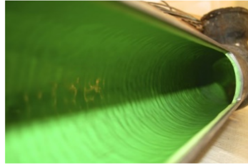
Rioolbuis voorzien van nieuwe binnenkant d.m.v. relinen.
